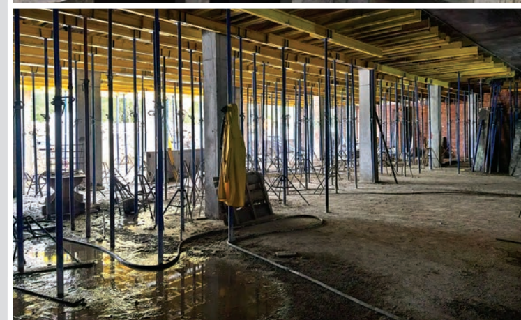
Верхнее фото: перспективы, открывающиеся с кровли здания музея. Среднее и нижнее фото: готовое пространство ждёт отделочных работ. Состояние объекта в июле 2026 года
